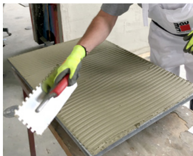
Pegado con el método de doble encolado con Baunit CeramicFix
