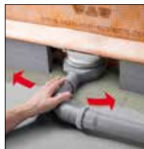
Fig. 5. Alineación de la tubería de desagüe
