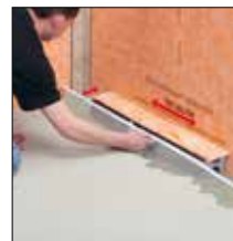
Fig. 4. Alineación del elemento portador para canaleta
