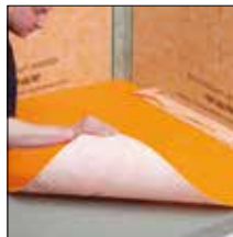
Fig. 7. Adhesión de Schlüter®-DITRA 25 o DITRA-HEAT
