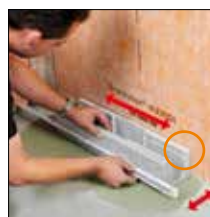
Fig. 1. Alineación del elemento portador para canaleta
