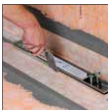
Fig. 3. Macizar la zona marco Instalar recubrimiento por el método del doble encolado.
