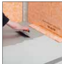
Fig. 7. Aplicación del cemento cola en capa fina
