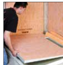
Fig. 3. Inserción del panel de pendiente debajo del borde de la canaleta
