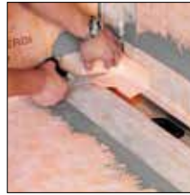
Fig. 2. Pegar el manguito KERDI con KERDI-COLL-L/Cortar la pieza de esquina interior KERECK
