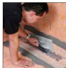
Fig. 4. Manguito KERDI adherir con KERDI-COLL-L
