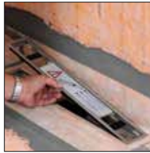
Fig. 1. Colocar el marco de contorno con la pieza especial separadora
