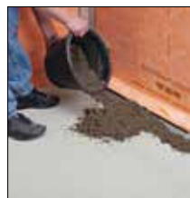
Fig. 3. Aplicación del recreado de mortero
