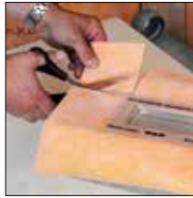
Fig. 1. Cortar el manguito KERDI
