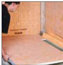
Fig. 3. Desplazamiento del panel de pendiente debajo del borde de la canaleta
