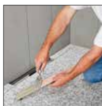
Fig. 5. Preparar la rejilla con cemento cola en capa fina
