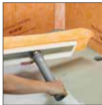
Fig. 2. Colocación del tubo de desagüe
