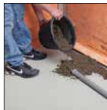
Fig. 6. Colocación del recrecido con pendiente
